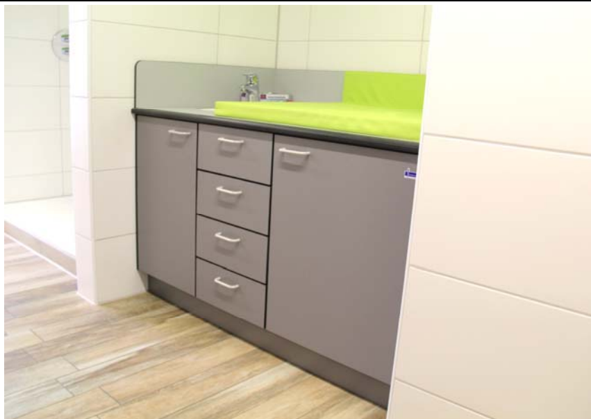
Wickelkommode mit Waschbecken und ausziehbarer Treppe rechts
